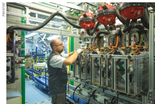
Зона испытания RM6
